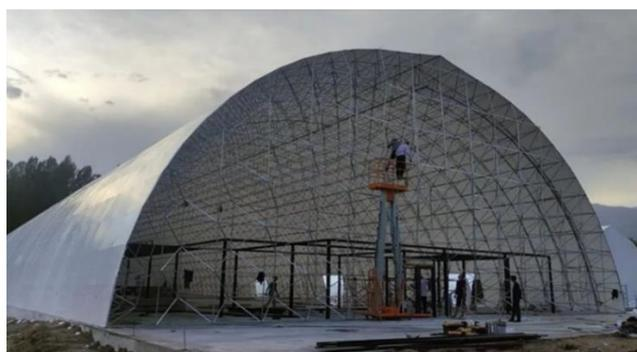
**Рис. 7.** Пространственный арочный каркас «Nomading» в процессе строительства<sup>15</sup>
