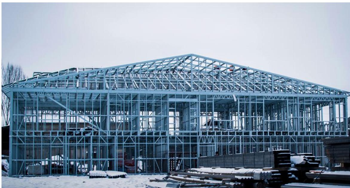
**Рис. 2.** Один из объектов компании DSKA Engineering – здание обувной фабрики Imperial Shoes в процессе строительства<sup>9</sup>
