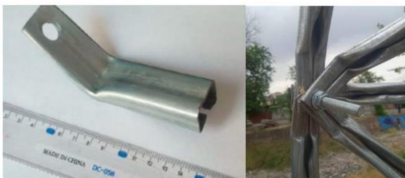
**Рис.6.** Тонкостенный стальной дважды гнутый профиль и узел соединения стержней такого профиля
