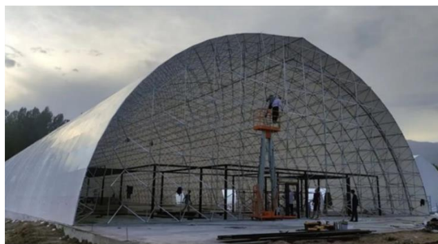
Рис. 7. Пространственный арочный каркас «Nomading» в процессе строительства 15 Fig. 7. Spatial frameworks of "Nomading" in the construction process 15
