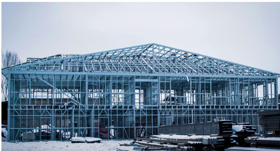
Рис. 2. Один из объектов компании DSKA Engineering – здание обувной фабрики Imperial Shoes в процессе строительства 9
