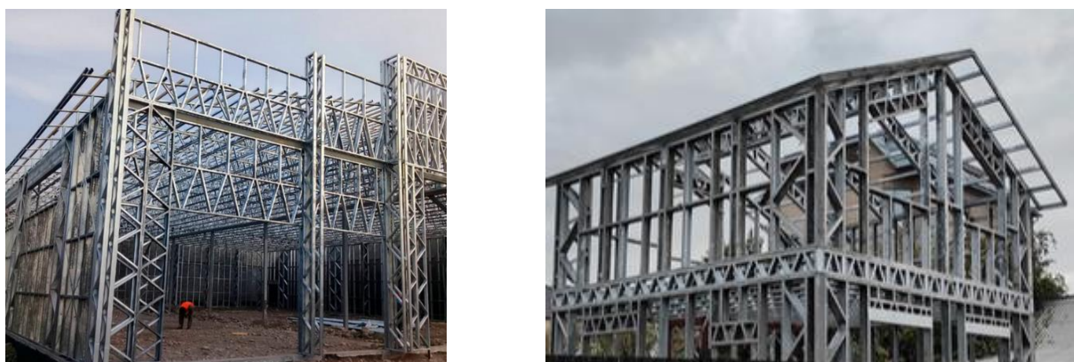
Рис. 3. Объекты компании «Karkas.kg» в процессе строительства – складской комплекс и двухэтажный жилой дом 10
