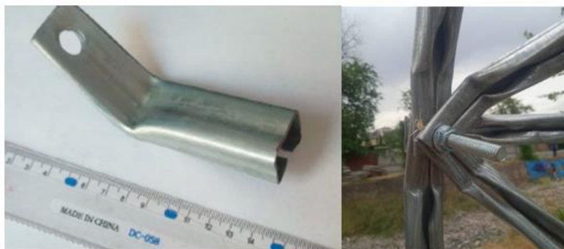
Рис.6. Тонкостенный стальной дважды гнутый профиль и узел соединения стержней такого профиля Fig.6. Thin-walled double-bent steel profile and the junction of the rods of such a profile
