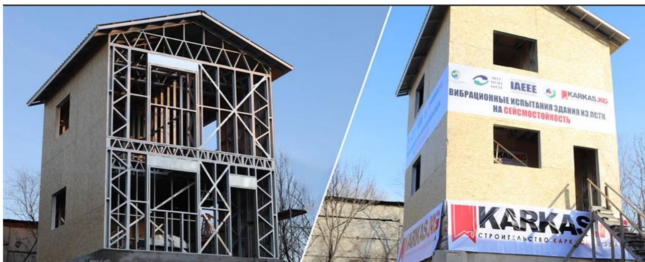
Рис. 4 – Фрагмент здания «Karkas.kg» в процессе вибродинамических испытаний 10 Fig. 4 – Fragment of the building "Karkas.kg" in the process of vibrodynamic tests 10
