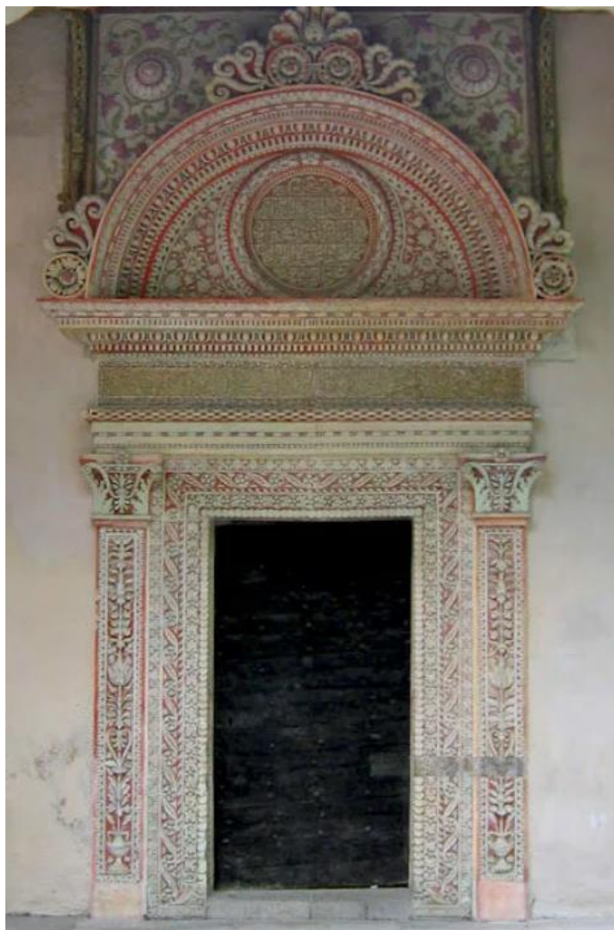
Рис. 2. Резной каменный портал (фото выполнено авторами при обследовании объекта)
