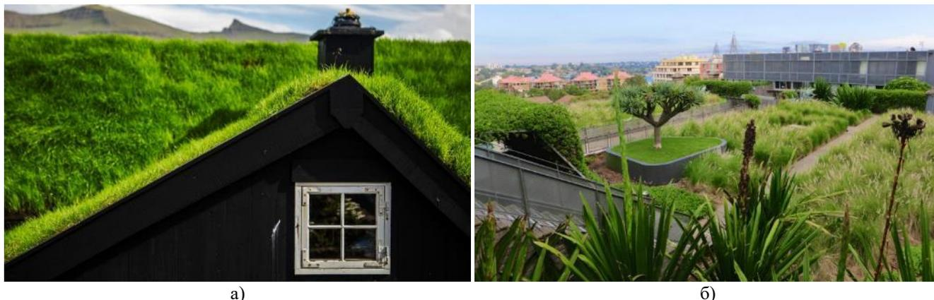
Рис. 4. Зеленые крыши и их виды: а – кровля экстенсивного типа; б – кровля интенсивного типа<sup>4</sup>
