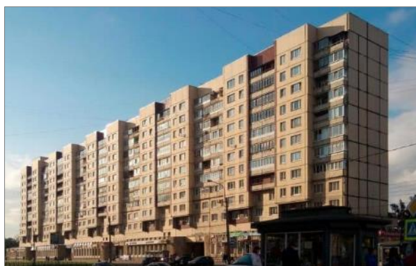
Рис. 1. Здание 137 серии 1 Fig. 1. Building 137 series
