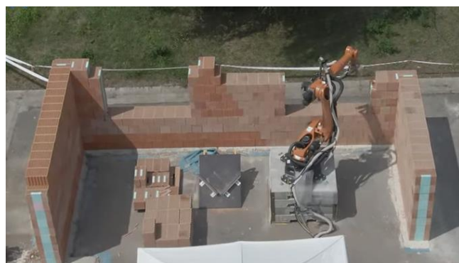
Рис.5. Выполнение работ по кирпичной кладке роботом KUKA 5 Fig. 5. Bricklaying with a KUKA robot
