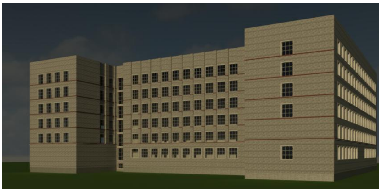
Рис.2. Здание учебно-лабораторного корпуса Fig.2. The educational and laboratory building
