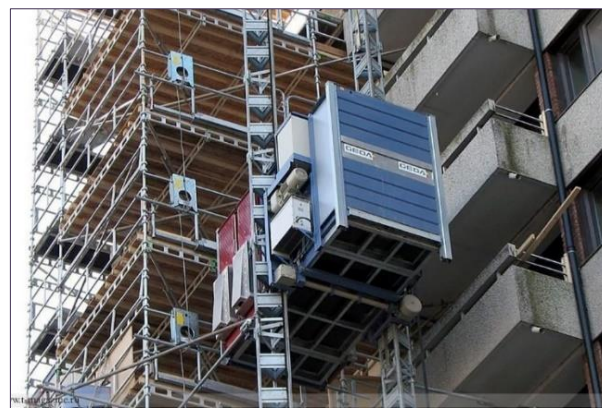
Рис. 4. Мачтовый подъемник 4 Fig. 4. Mast lift
