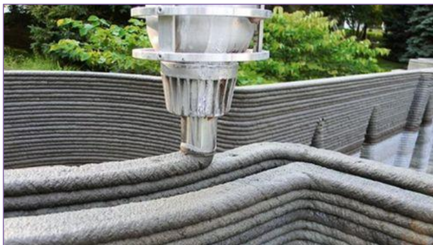
Рис. 6. Пример 3D-печати, с помощью бетонной смеси [10]
