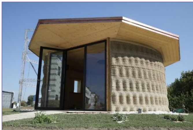
Рис. 12. Пример дома, напечатанный с помощью послойного экструдирования 10 Fig. 12. An example of a house printed using layer-by-layer extrusion
