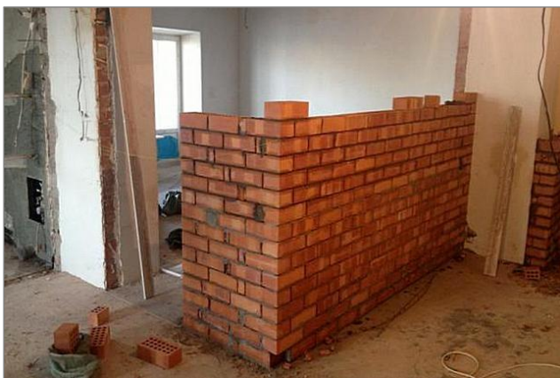
Рис. 1. Перегородка из кирпича 1 Fig. 1. Brick partition
