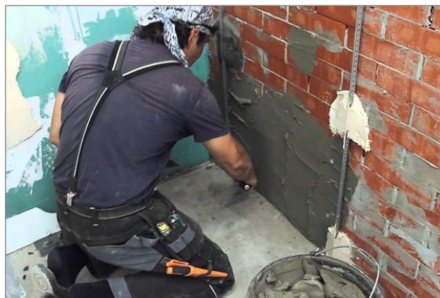
Рис. 2. Оштукатуривание кирпичной перегородки 2 Fig. 2. Plastering a brick wall
