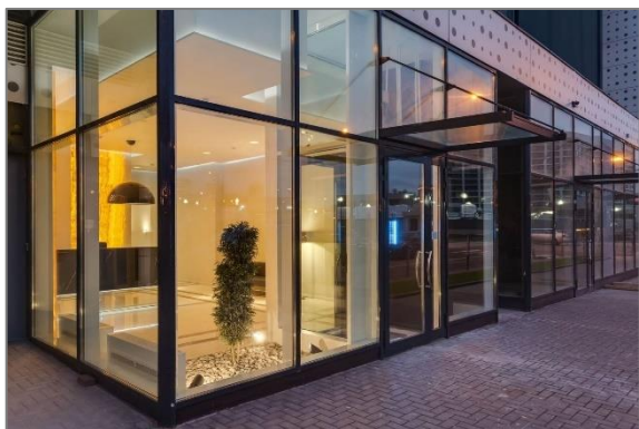
Рис.1. Стойчно-ригельная система остекления 1 Fig. 1. Post-transom glazing system
