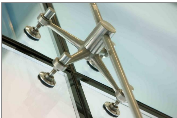
Рис.4. Кронштейн-спайдер 4 Fig. 4. Bracket spider
