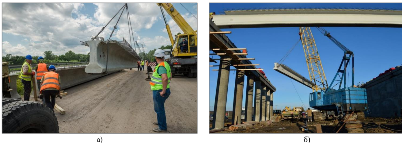
Рис. 3. Возведение пролетных строений: а - балки пролетного строения, б - монтаж ребристого пролетного строения 3 Fig. 3. Construction of superstructures: a - superstructure beams, б - installation of ribbed superstructure
