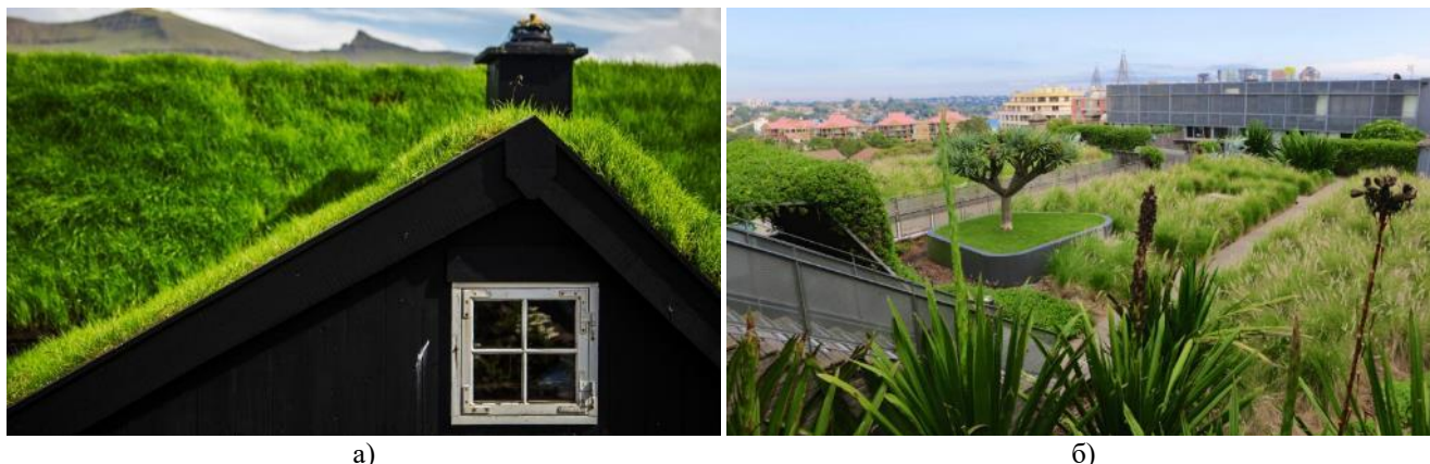
Рис. 4. Зеленые крыши и их виды: а – кровля экстенсивного типа; б – кровля интенсивного типа 4 Fig. 4. Green roofs and their types: a – extensive type roofing; b – intensive type roofing
