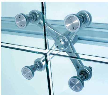
Рис. 3. Спайдер-кронштейн 2 Fig. 3. Spider bracket
