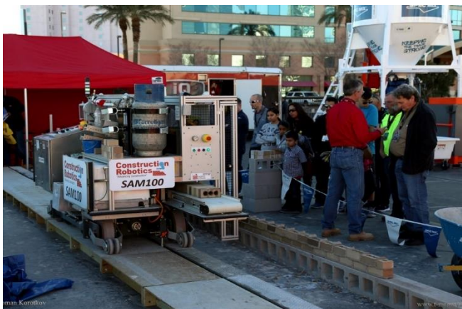
Рис. 1. Робот-каменщик SAM100 1 Fig.1. Mason robot SAM100
