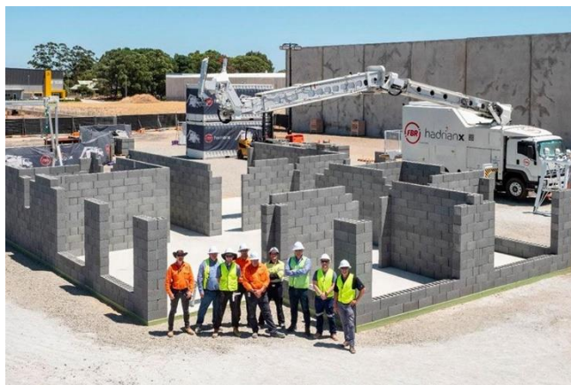
Рис. 2. Укладка каменных блоков роботом HADRIAN X 2 Fig. 2. Stone block laying with the HADRIAN X robot
