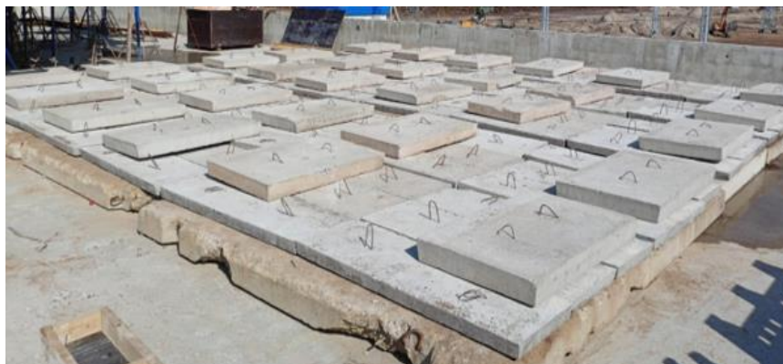
Рис. 7. Третий этап нагружения дорожными плитами Fig. 7. The third stage of loading with road slabs
