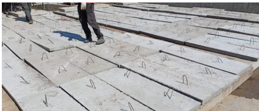
Рис. 6. Второй этап нагружения дорожными плитами Fig. 6. The second stage of loading with road slabs
