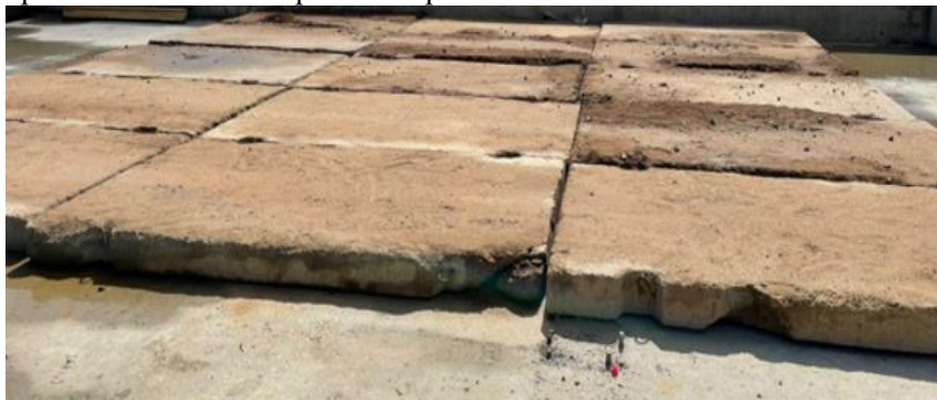
Рис. 5. Первый этап нагружения дорожными плитами Fig. 5. The first stage of loading with road slabs
