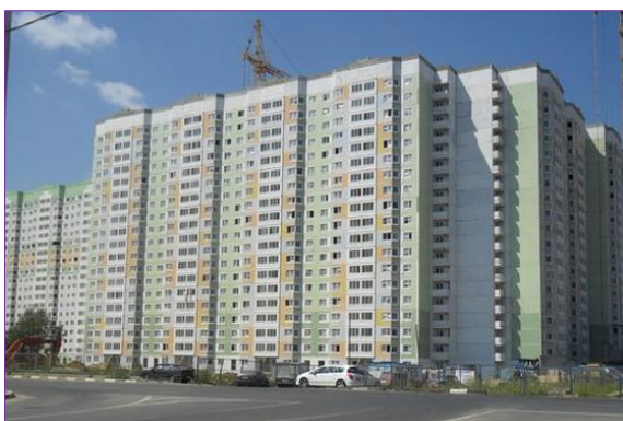
Рис. 4. Панельный дом серии И-155 3 Fig. 4. Panel house of the I-155 series
