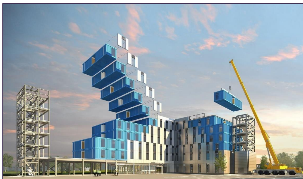
Рис. 5. Процесс монтажа многоэтажного модульного здания 8 Fig. 5. Installation process of a multi-storey modular building
