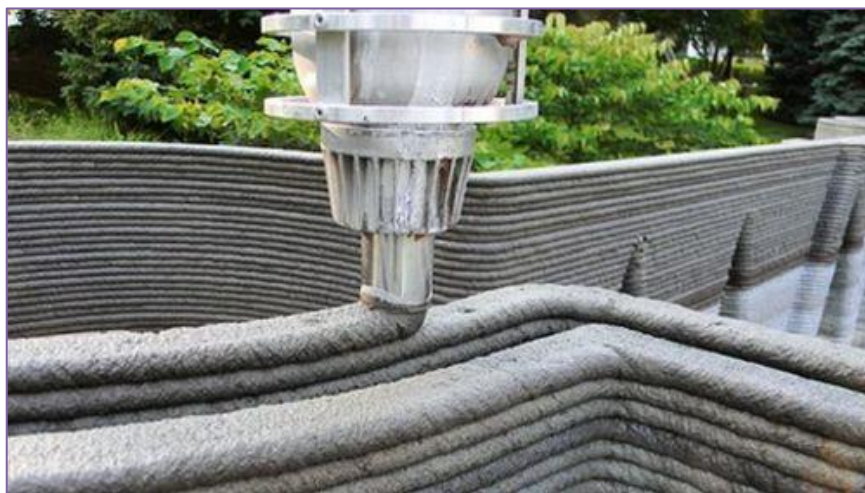
Рис. 6. Пример 3D-печати, с помощью бетонной смеси [10]
