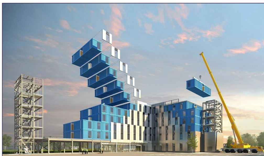
Рис. 5. Процесс монтажа многоэтажного модульного здания 8 Fig. 5. Installation process of a multi-storey modular building
