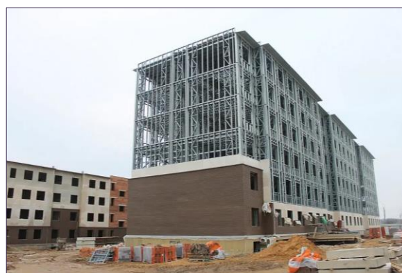
Рис. 2. Процесс строительства здания из ЛСТК 4 Fig. 2. The process of building a building from , LGSS
