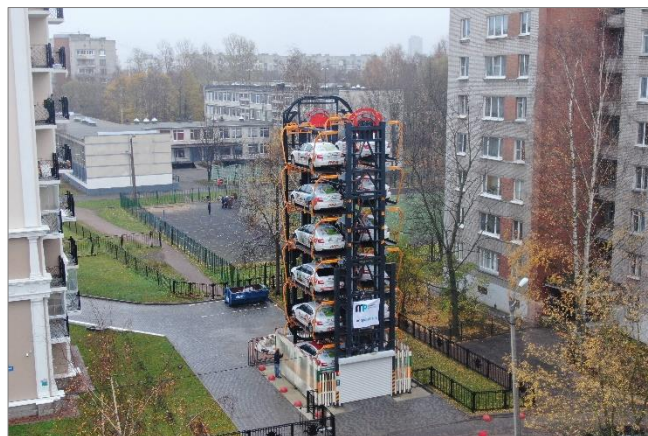
Рис.10. Испытание под нагрузкой роторной (карусельной) парковки в Санкт-Петербурге 6 Fig.10. Load test of rotary (carousel) parking in St. Petersburg
