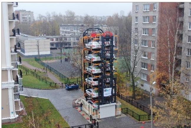
**Рис.10.** Испытание под нагрузкой роторной (карусельной) парковки в Санкт-Петербурге<sup>6</sup>
