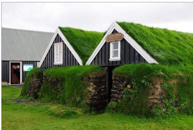
Рис. 9. Зеленая кровля крыши 7 Fig. 9. Green roof
