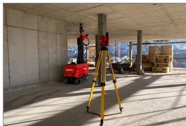
Рис. 1. Строительный робот Hilti Jaibot с поддержкой BIM 1 Fig. 1. Hilti Jaibot construction robot with BIM support
