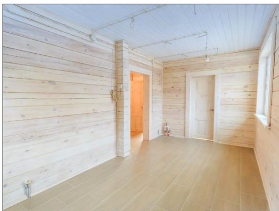
Рис. 9. Стационарная деревянная перегородка 7 Fig. 9. Stationary wooden partition
