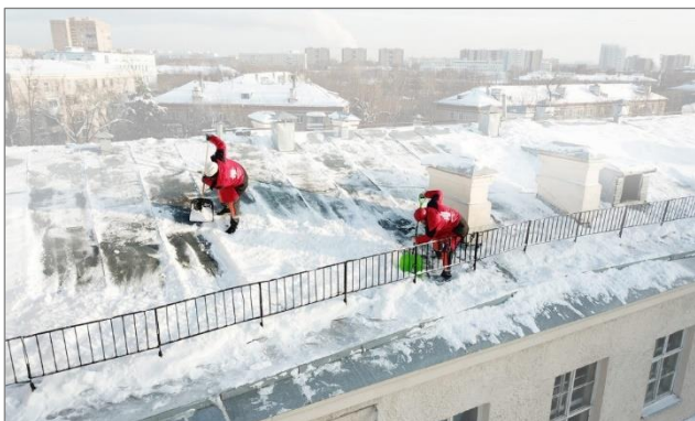
Рис. 5. Механический способ борьбы с обледенением 5 Fig. 5. Mechanical method for dealing with icing
