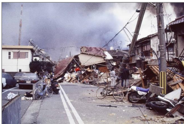
Рис. 2. Разрушение домов вдоль дороги, г. Кобе (Япония, 1995 г.) 2
