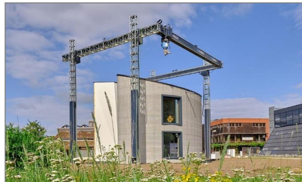
Рис. 7. 3D-принтер портального типа 5 Fig. 7. Gantry type 3D printer
