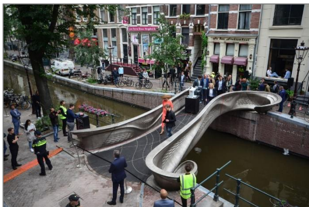
Рис. 8. Мост, построенный по технологии WAAM 6 Fig. 8. Bridge built with WAAM technology
