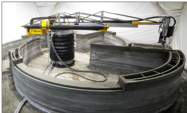
Рис. 6. 3D-принтер с роботизированной рукой 4 Fig. 6. Robotic Arm 3D Printer
