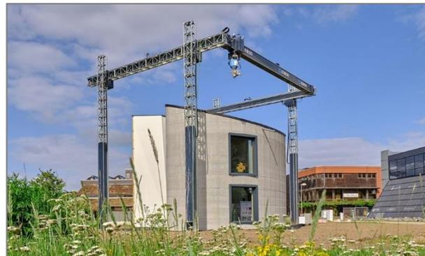
**Рис. 7.** 3D-принтер портального типа<sup>5</sup>
