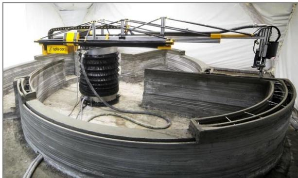
**Рис. 6.** 3D-принтер с роботизированной рукой<sup>4</sup>
