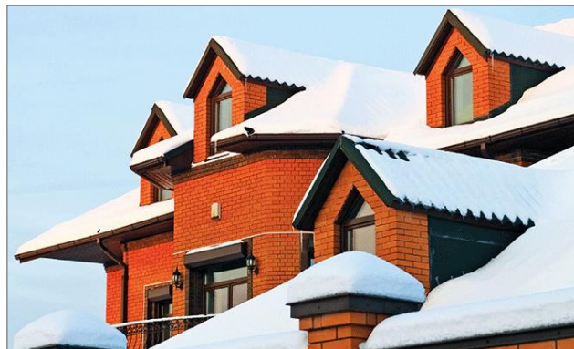
Рис. 4. Сложная конструкция крыши 4 Fig. 4. Complex roof structure
