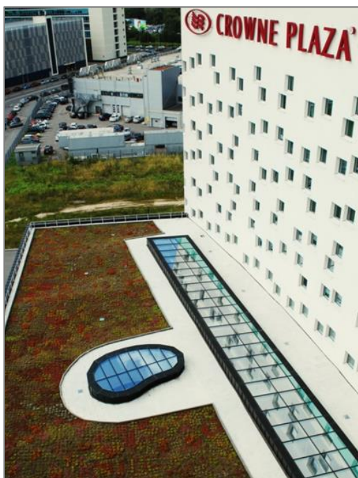
Рис. 4. Экстенсивная кровля гостиницы Crowne Plaza, г. Санкт-Петербург 3
