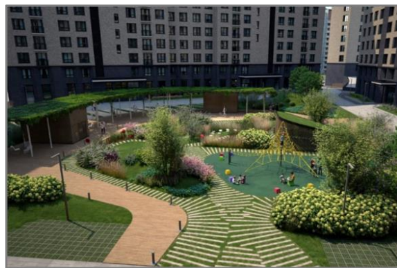
Рис. 2. Интенсивная кровля подземного паркинга ЖК «Only» г. Москва 2
