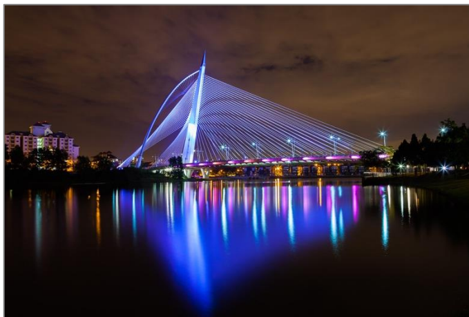
Рис. 12. Seri Wawasan Bridge, Путраджая, Малайзия 12 Fig. 12. Seri Wawasan Bridge, Putrajaya, Malaysia
