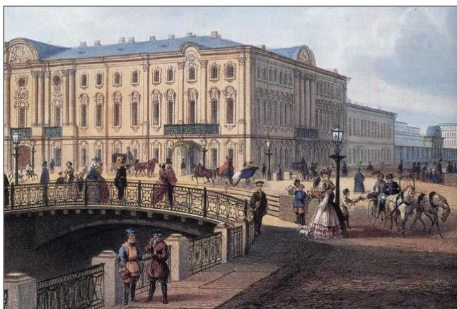
Рис. 4. Полицейский мост, 1840-е 4 Fig. 4. Police bridge, 1840s
