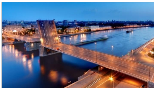
Рис. 7. Володарский мост после реконструкции в 1988 г. 7 Fig. 7. Volodarsky bridge after reconstruction in 1988
