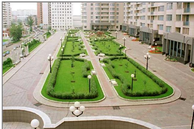
Рис. 6. Обустройство кровли паркинга ЖК «Дом Газпрома», г. Москва 5 Fig. 6. Arrangement of the roof of the parking lot of the residential complex "Gazprom House", Moscow
