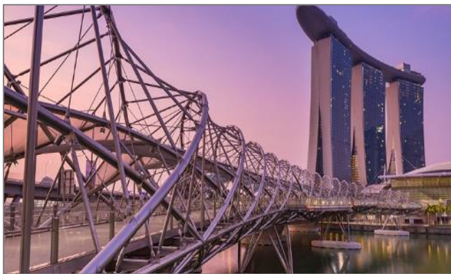
Рис. 10. Хеликс Бридж (The Helix Bridge), Марина-Бэй, Сингапур 10 Fig. 10. The Helix Bridge, Marina Bay, Singapore
