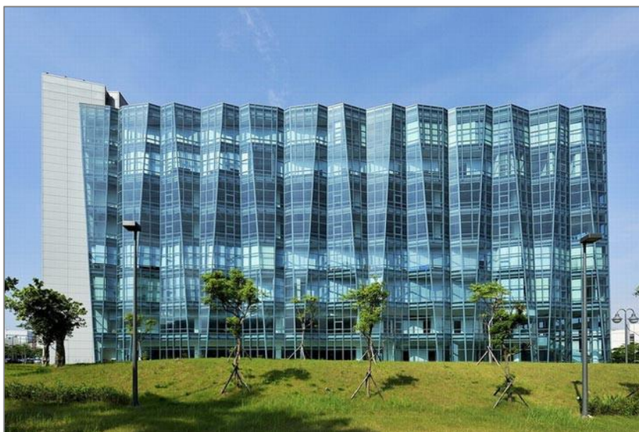
Рис. 7. Граненый светопрозрачный фасад (штаб-квартира Neo Solar Power Corporation) 5 Fig. 7. Faceted translucent facade (headquarters of Neo Solar Power Corporation)
