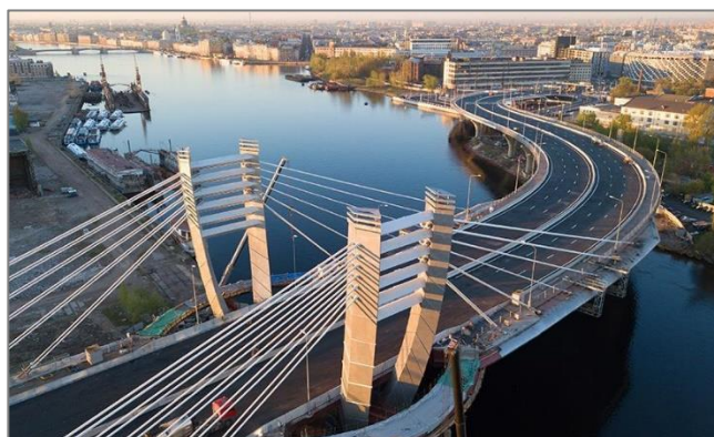
Рис. 14. Мост Бетанкура 14 Fig. 14. Betancourt bridge
