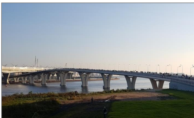
Рис. 13. Яхтенный мост 13 Fig. 13. Yacht bridge
