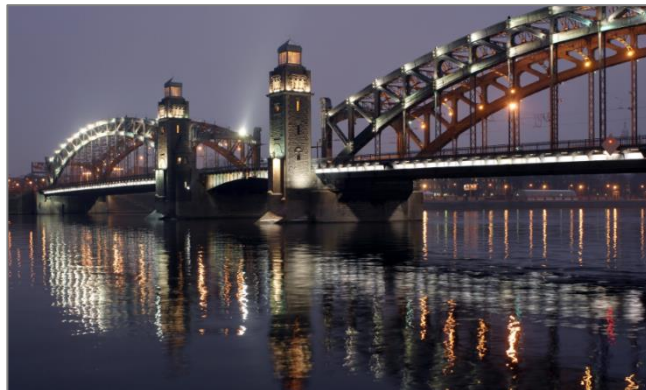
Рис. 9. Большеохтинский мост после ремонта 9 Fig. 9. Bolsheokhtinsky bridge after repair
