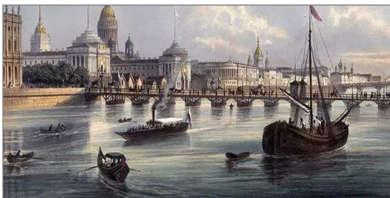
Рис. 2. Исаакиевский наплавной мост 2
