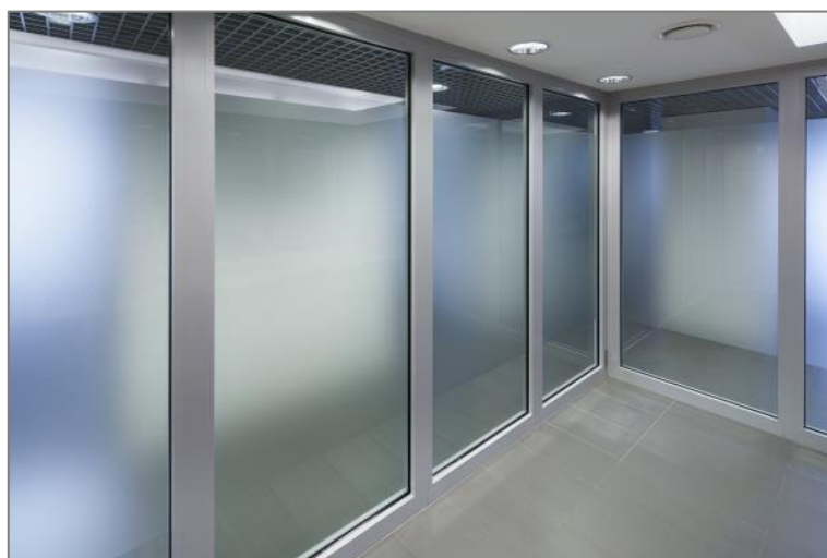
Рис. 3. Противопожарная перегородка 1-го типа, выполненная из металлических конструкций с остеклением 3 Fig. 3. Firewall of the 1st type, made of metal structures with glazing
