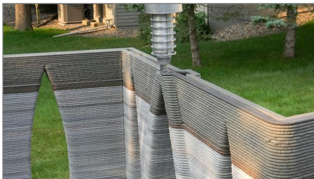
Рис. 1. Процесс печати основной части замка 1 Fig. 1. The process of printing the main part of the castle
