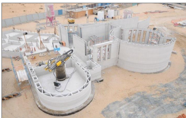
Рис. 5. Здание, построенное с помощью 3D-принтера компанией Apis Core 4 : а - процесс печати, б – готовое здание Fig. 5. A building built with a 3D printer by Apis Core: a - printing process, b - finished building
