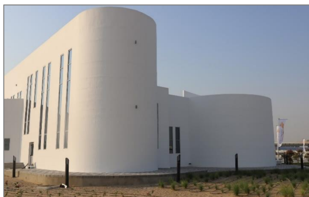
Рис. 5. Здание, построенное с помощью 3D-принтера компанией Apis Core 4 : а - процесс печати, б – готовое здание Fig. 5. A building built with a 3D printer by Apis Core: a - printing process, b - finished building
