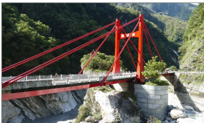
Рис.11. Висячий мост в Тароко, Тайвань 11 Fig. 11. Suspension bridge in Taroko, Taiwan
