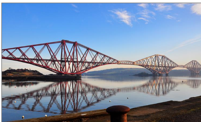
Рис.13. Мост Форт-бридж в Шотландии 13 Fig. 13. Fort bridge in Scotland
