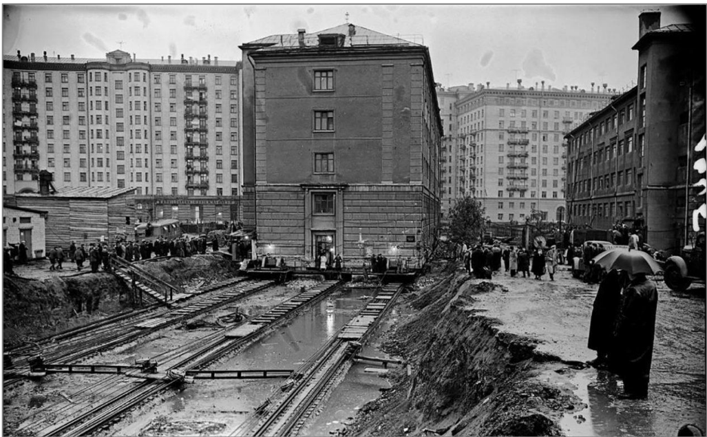
Рис.1. Перемещение здания на Каланчёвской улице, г. Москва 1 Fig.1. Relocation of the building on Kalanchevskaya street, Moscow
