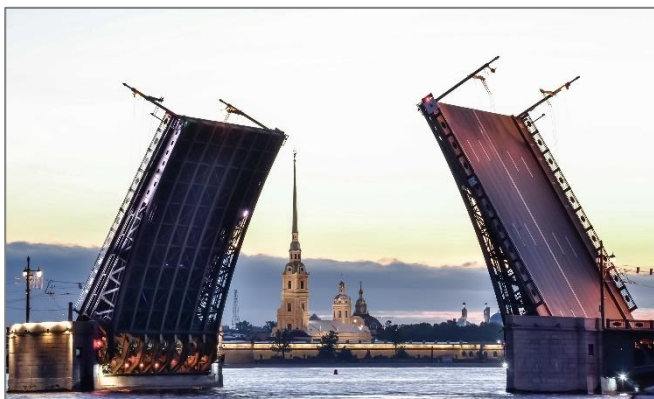
Рис.9. Дворцовый мост в Санкт-Петербурге, Россия 9 Fig. 9. Palace Bridge in Saint Petersburg, Russia
