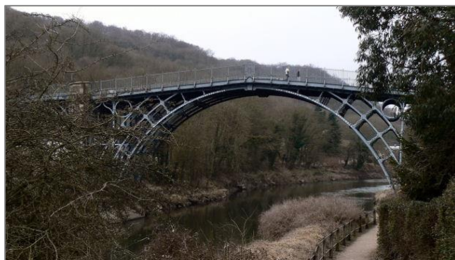
Рис.4. Первый железный мост через р. Северн, Англия 4 Fig. 4. First iron bridge over the River Severn, England
