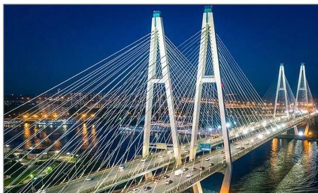
Рис.12. Большой Обуховский мост, Санкт-Петербург 12 Fig. 12. Big Obukhovskiy bridge, Saint Petersburg
