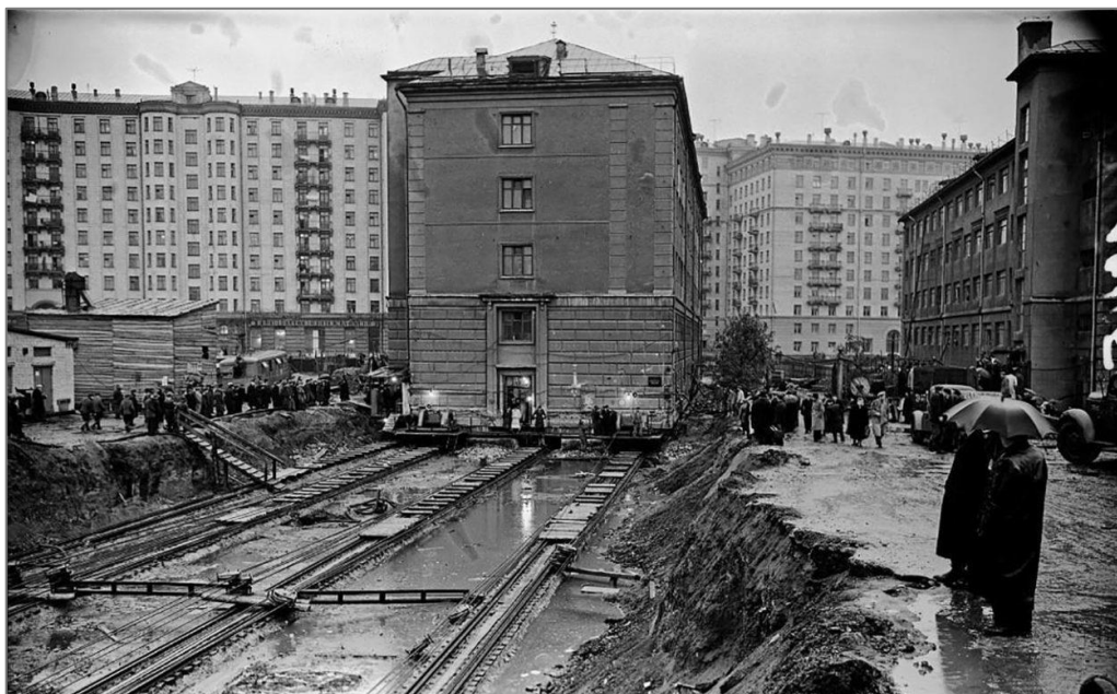
Рис.1. Перемещение здания на Каланчёвской улице, г. Москва 1 Fig.1. Relocation of the building on Kalanchevskaya street, Moscow
