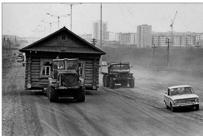
Рис.4. Перевозка дома в Набережных Челнах, 1972 год [4] Fig.4. Transportation of a house in Naberezhnye Chelny, 1972
