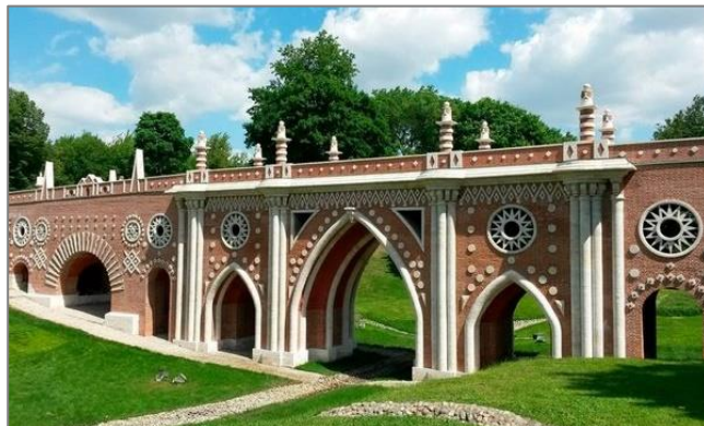
Рис. 2. Большой мост через овраг в Царицыно 2 Fig. 2. Big bridge over the ravine in Tsaritsyno
